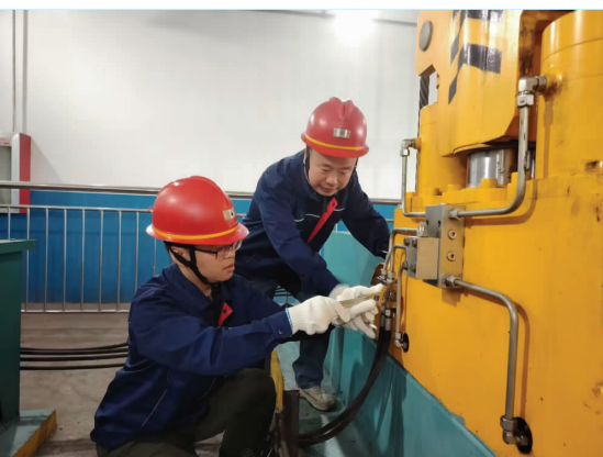
近日,二矿机电工区维运四队紧抓安全不放松,全面加强基础设备的安全管理。图为维护工正在紧固双码秤装置螺栓。
