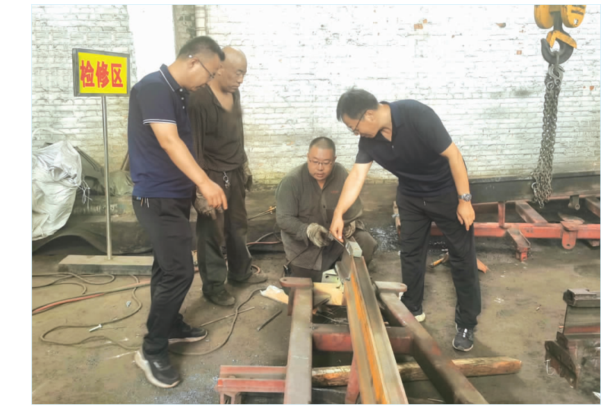
近期,开元公司运输部特邀专业技术人员现场指导单轨吊道岔的修复技术。截至目前,通过对道岔进行拆解、焊接、重组、更换短接头、平直轨道等措施,修复单轨吊道岔6套,修旧利废价值28.2万元。
