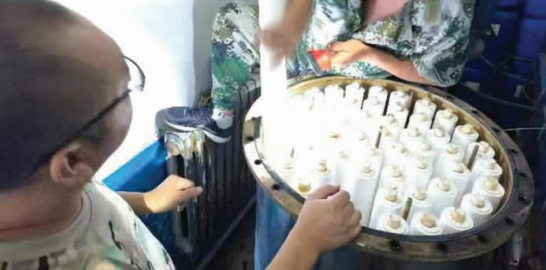
近日,一矿生产生活服务中心对软化水设施进行了维修更新,确保职工澡堂用水。董俊华摄
